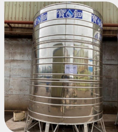
節水計畫新增 2 座共 20 噸造粒回收水桶槽
