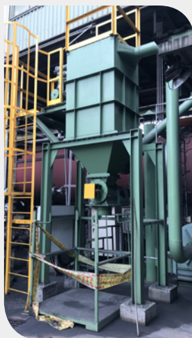
2K 空冷窯新製集塵機工程
