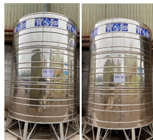
節水計畫新增 2 座共 20 噸造粒用回收水桶槽
