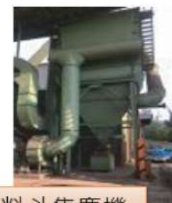
造粒廠進料斗集塵機
