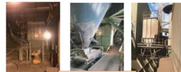
進料斗集塵機
